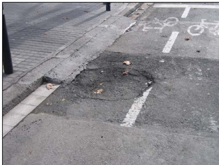
Ferm en mal estat al carril bici
