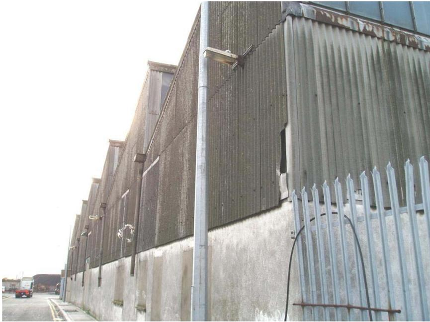
**Fotografía 4.10** Revestimiento externo de fibrocemento en una fábrica.
