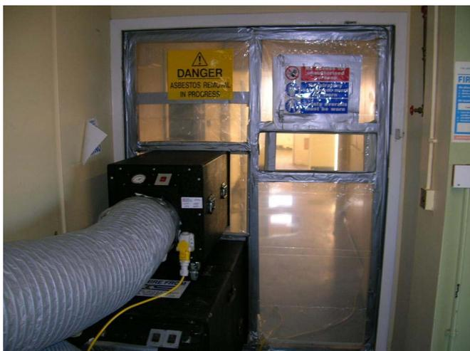
**Fotografía 12.2** Sistemas de depresión y conductos de evacuación del aire, ventanillas y señales de advertencia.
