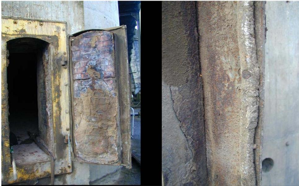
**Fotografía 4.12** Cuerda de amianto que sella la puerta de una chimenea. La imagen de la derecha muestra la cuerda de cerca.
