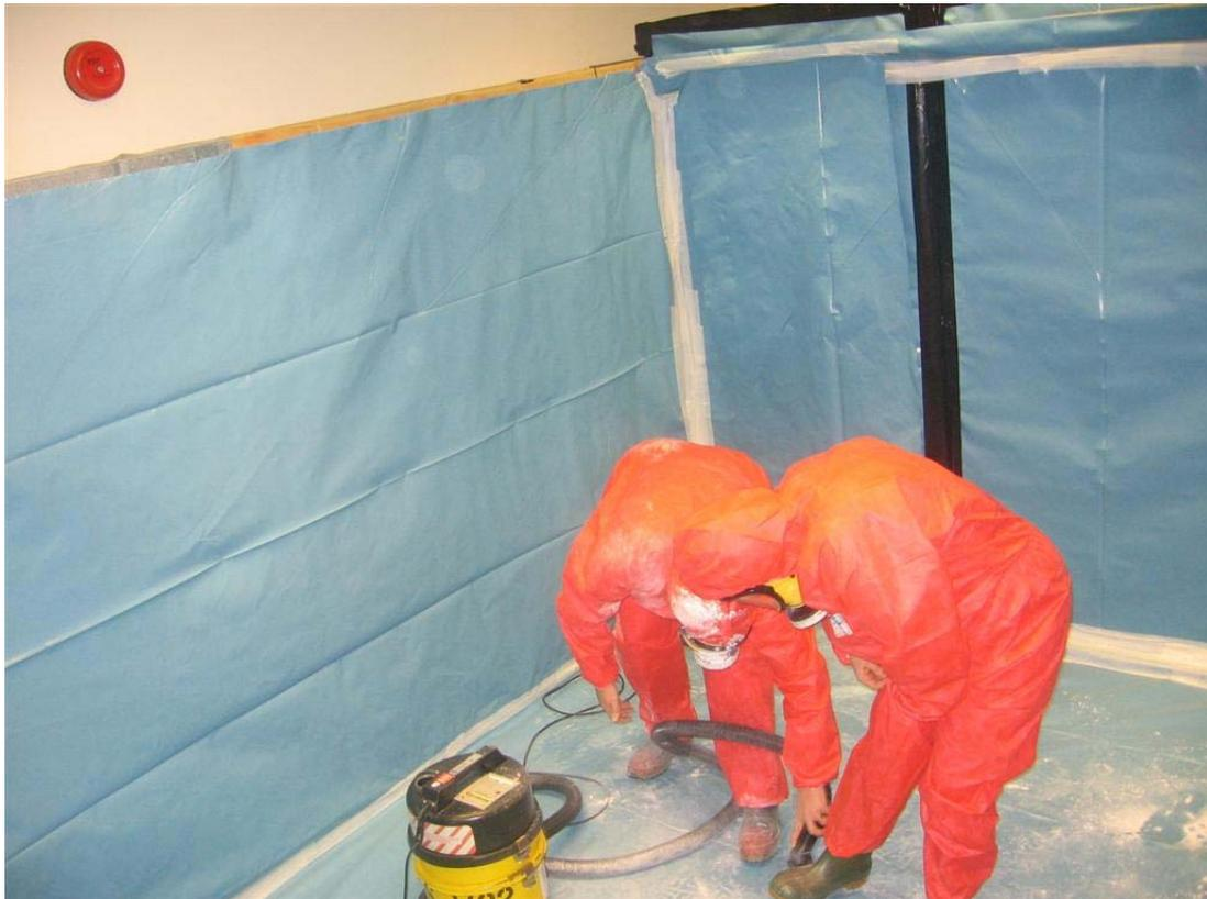
**Fotografía 7.1** Formación práctica en el manejo de los aspiradores de clase H para retirar lo que simula ser material contaminante (polvos de talco). Fotografía cedida por el HSE del Reino Unido.
