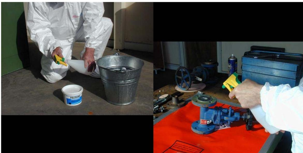
**Fotografía 11.4** Humectación de una junta de amianto de la válvula.
