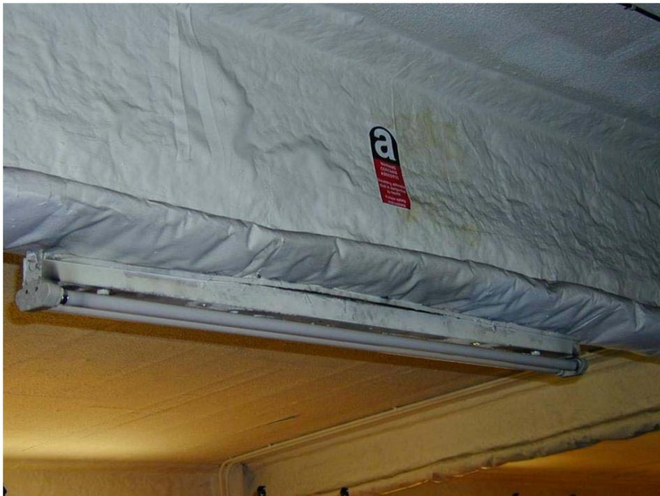
**Fotografía 4.11** Aislamiento de amianto en una estructura de acero.
