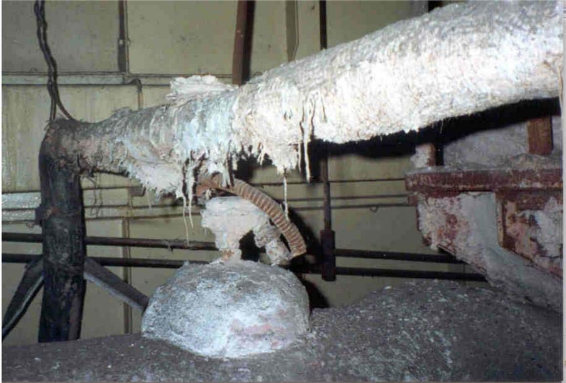
**Fotografía 4.8** Aislamiento de amianto en tuberías de vapor.
