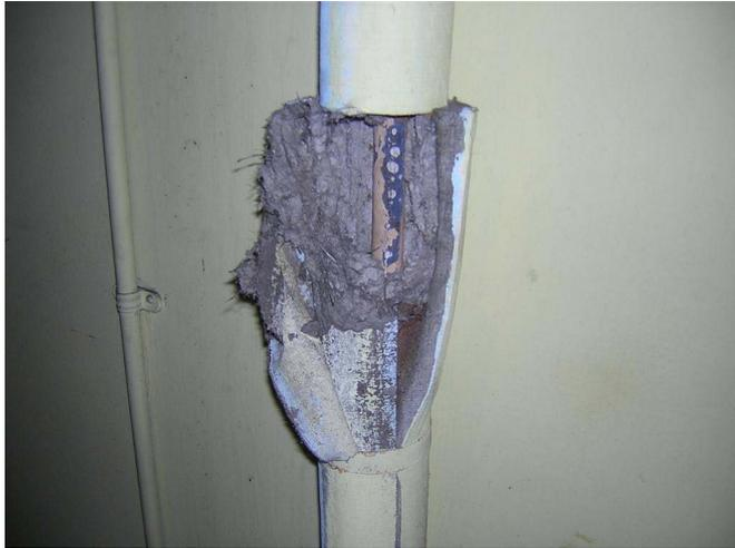
**Fotografía 12.7** Aislamiento de una tubería con múltiples capas de amianto y penetración del agente humectante.
