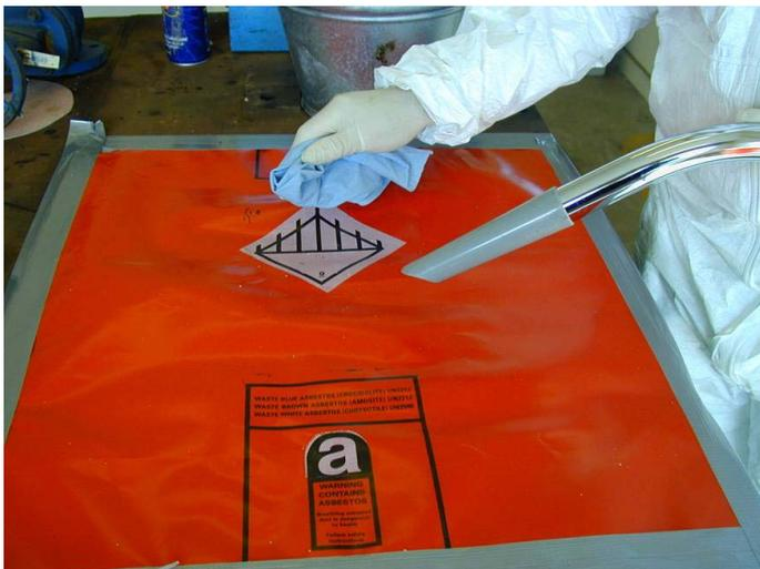
**Fotografía 11.7** Limpieza minuciosa de la zona de trabajo con un aspirador de clase H y trapos húmedos.
