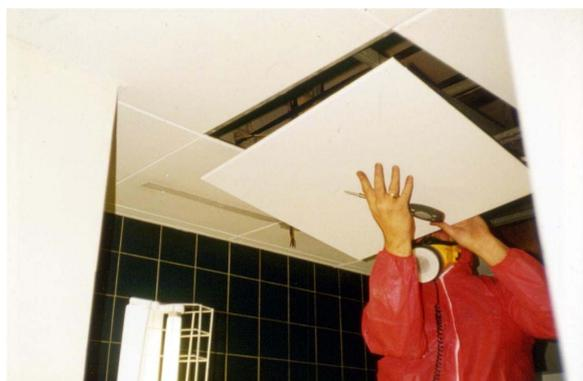
**Fotografía 12.13** Retirada de una placa de amianto del techo adoptando las precauciones necesarias.
