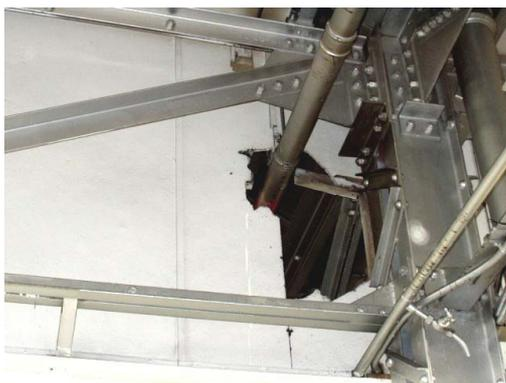
**Fotografía 4.3** Tabique de separación de tablero aislante de amianto. Este ejemplo ilustra las dificultades que se encuentran en la práctica para construir un confinamiento adecuado, así como las superficies en las que el polvo de amianto puede acumularse durante el proceso de retirada.
