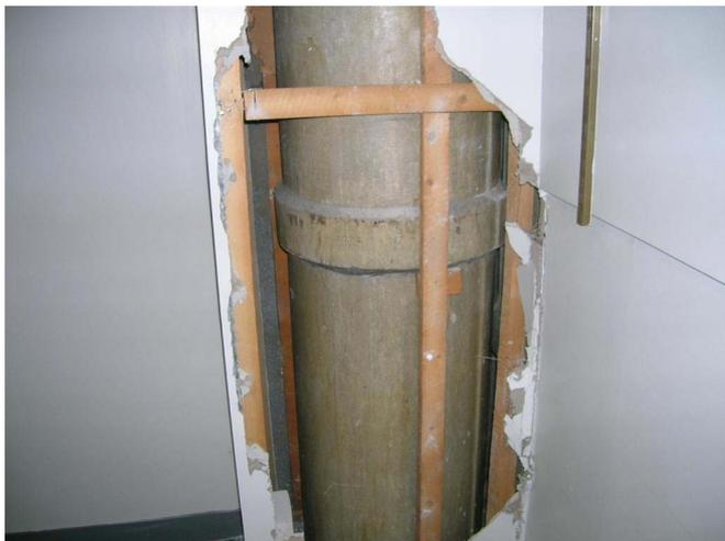
**Fotografía 4.2** Caja de tablero aislante de amianto parcialmente retirada para mostrar el conducto de evacuación de humos de fibrocemento que esconde en su interior.
