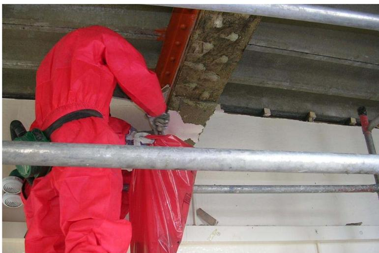
**Fotografía 12.11** Un operario deposita los residuos en una bolsa junto al punto en el que se realizan los trabajos de retirada para evitar la dispersión del amianto y minimizar la exposición.
