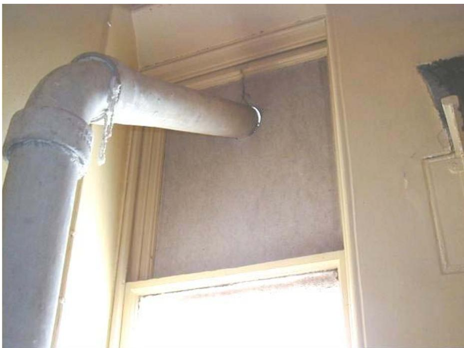
**Fotografía 4.5** Conducto de evacuación de humos de fibrocemento sellado con cuerda de amianto que pasa a través de un panel de relleno de amianto.
