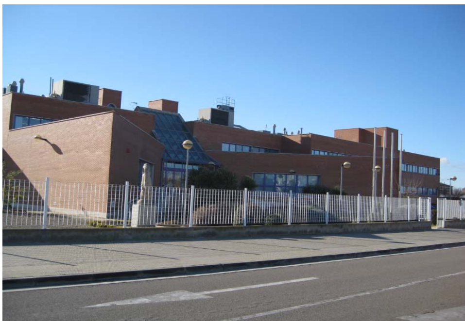
Vista del edificio con equipos climatización en cubierta
