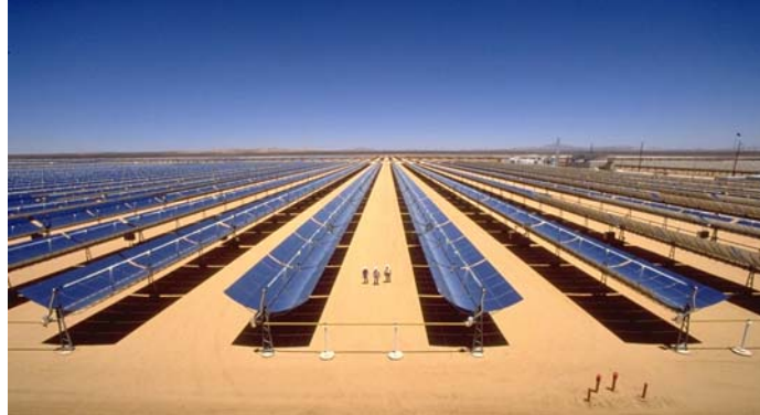
Fotografía A1.3. Campo de colectores ccps
