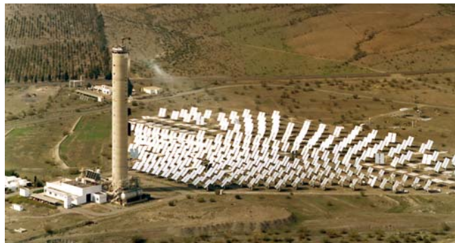
Fotografía A1.4. Campo de helióstatos y receptor central plataforma solar de Almería
