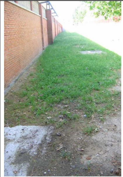
espacio habilitable lateral sur accesos oeste
