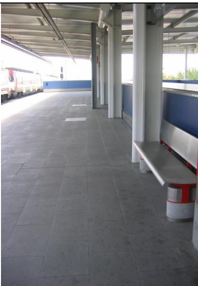
andén norte lateral oeste
