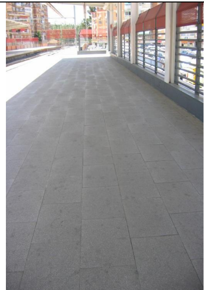
andén norte lateral oeste
