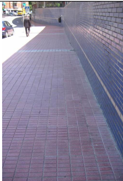
acera exterior accesos norte
