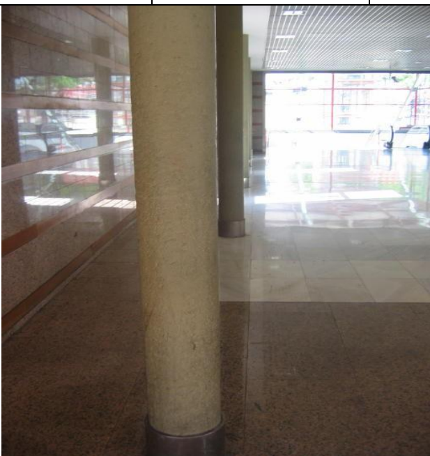
vestíbulo accesos oeste
