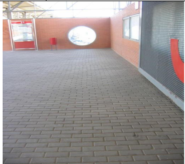
hall cubierto andén norte
