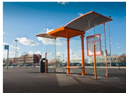
MARQUESINA DEL I-BUS
